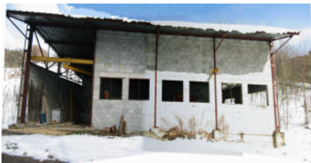
La friche actuelle sur le terrain acheté par ACTIS. N'oublions pas que cette opération a pour objectif de construire des logements sociaux et de faire disparaître une friche artisanale au cœur du village.
